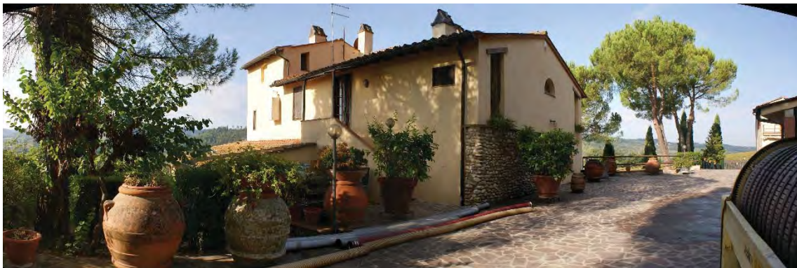
Foto 12 – Vista frontale del Fabbricato A
