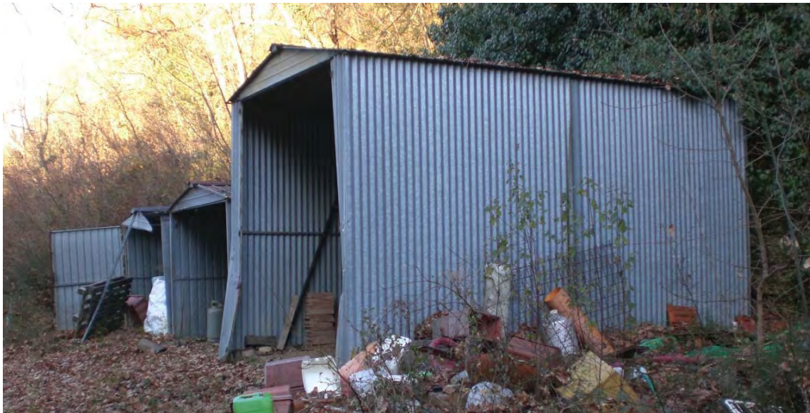
Foto 16 – Vista laterale dei Fabbricati D
