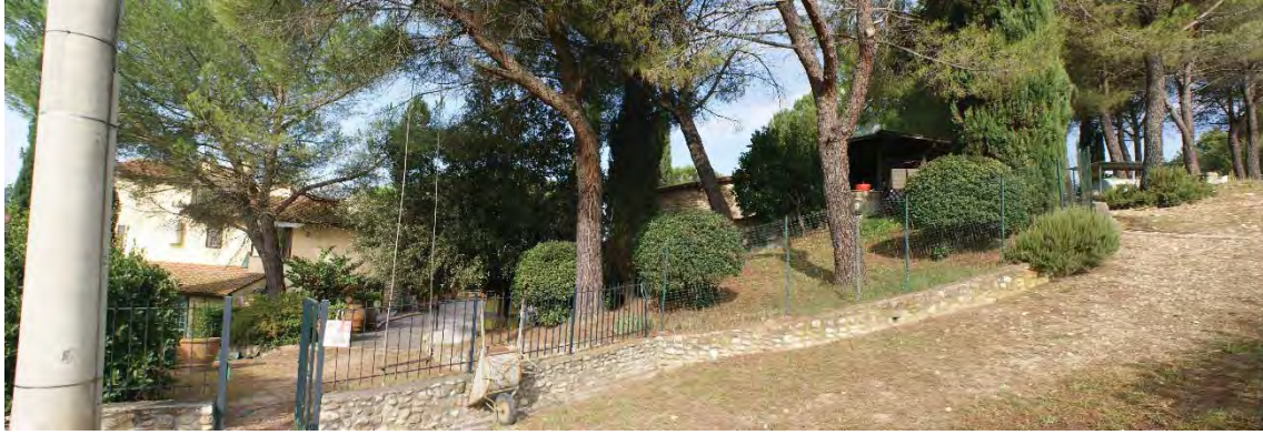
Foto 10 – Vista da Est del complesso immobiliare
