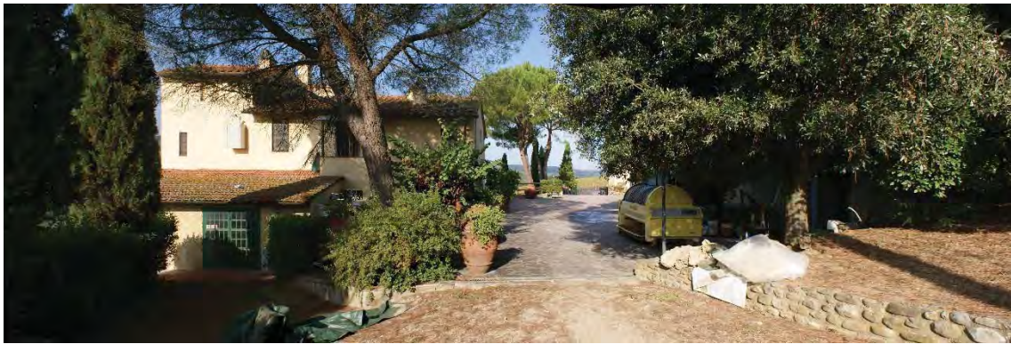
Foto 11 – Vista laterale Fabbricato A
