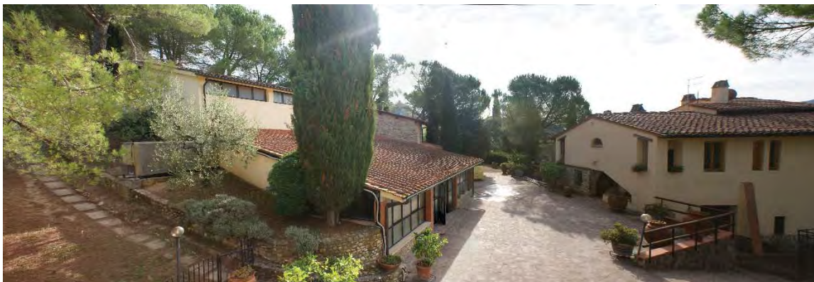
Foto 6 – Vista del Fabbricato A e del Fabbricato B
