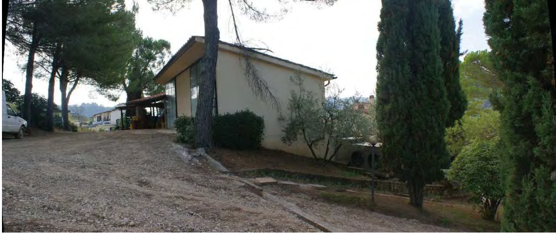
Foto 7 – Vista laterale del Fabbricato B
