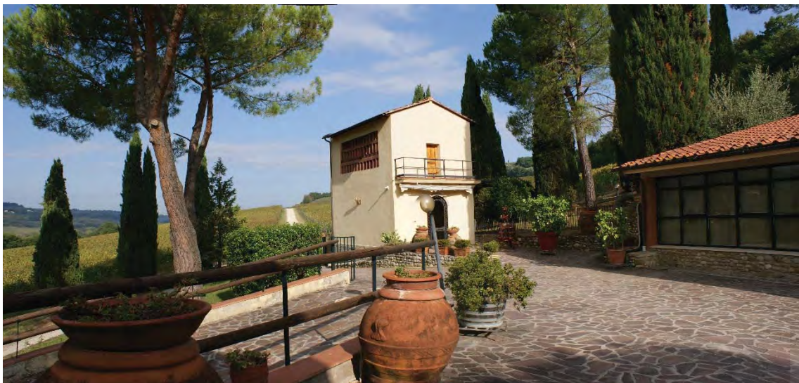
Foto 14 – Vista frontale del Fabbricato C
