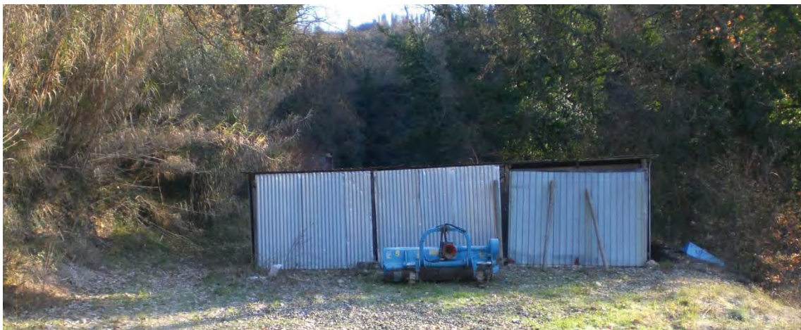
Foto 16 – Vista frontale di uno dei Fabbricati D
