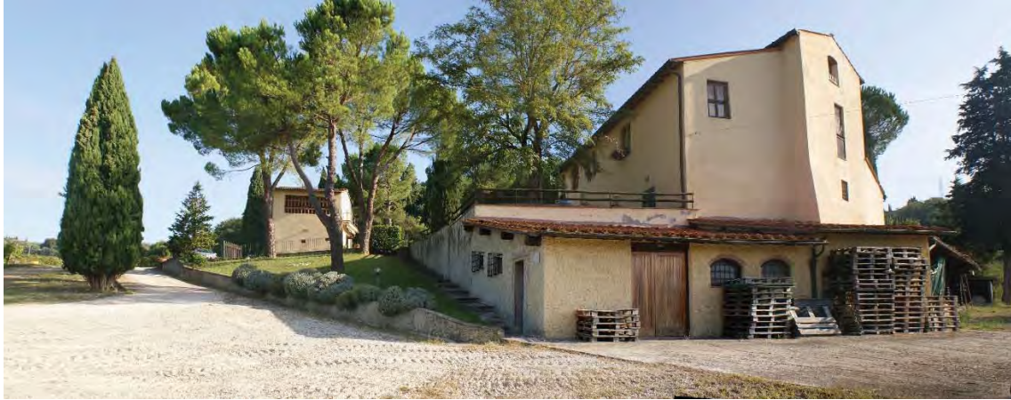
Foto 4 – Fabbricato A, parte tergaie
