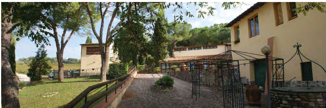
Foto 15 – Vista laterale del Fabbricato A e del fabbricato C
