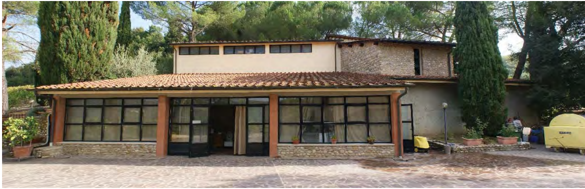
Foto 13 – Vista frontale del Fabbricato B
